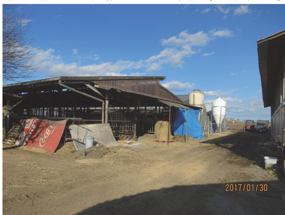
写真 初期建築の資材置き場
