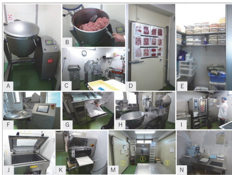
写真2 原料処理の設備
